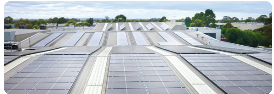
在Keysborough廠址使用太陽能板
